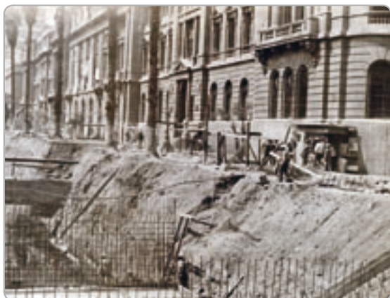
En el gobierno de Augusto Pinochet se terminó la primera línea del metro de Santiago. Su construcción se inició en el gobierno de Eduardo Frei.
