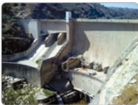
La ENDESA fue la empresa encargada de dotar electricidad al país y lo hizo a través de la construcción de centrales hidroeléctricas, como la de Rapel que aparece en la imagen.
