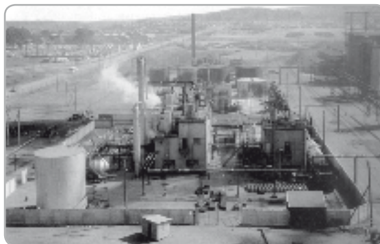
La Compañía de Acero del Pacífico se creó en el marco del proceso industrializador. En la imagen, la industria siderúrgica de Huachipato.
